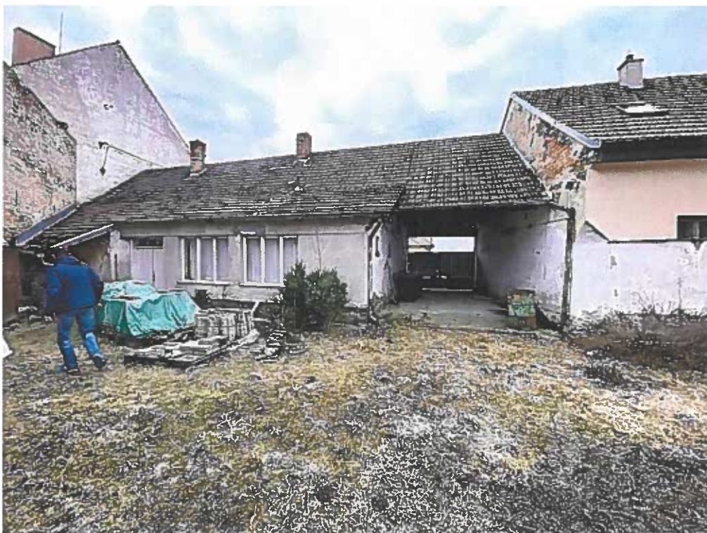
Dvorní pohled na rodinný dům č.p. 68
