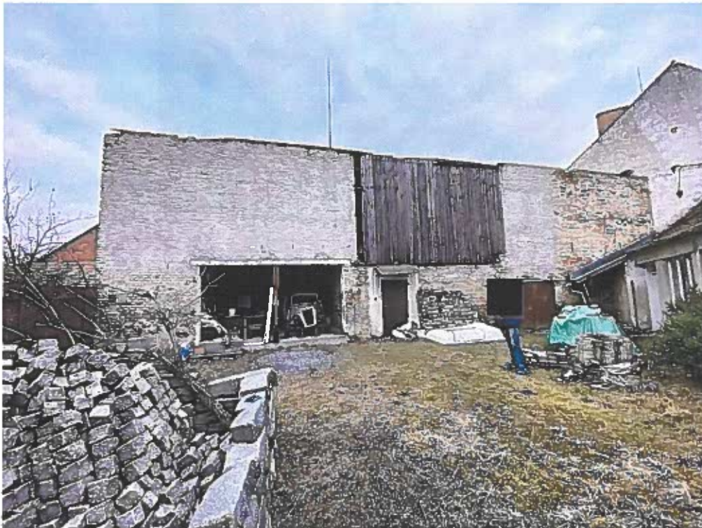
Pohled na přístavbu garáže od sousedního rodinného domu č.p. 68
