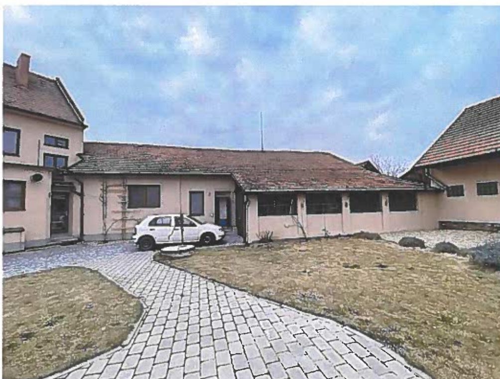
Pohled na navazující dvorní křídlo a přístavbu garáží.
