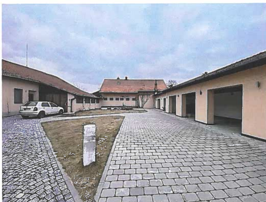
Pohled do nádvoří budovy restaurace, nalevo je navazující přístavba garáží a napravo je kuželna
