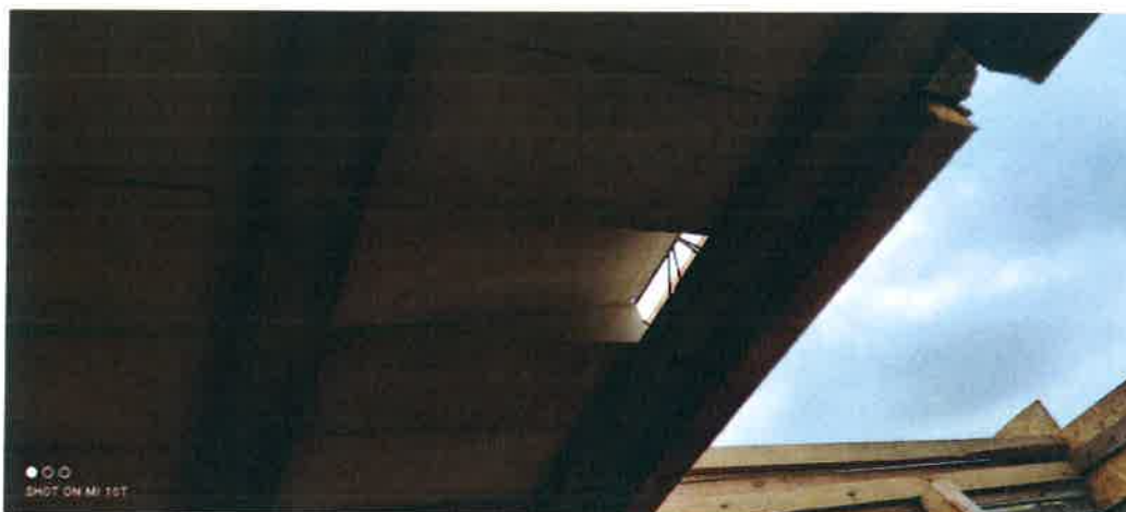
Obr. 10 – stropní nosníky ze systému Ytong klasik a místo stropních vložek výšky 200 mm jsou osazeny příčkovky Ytong tl. 100 mm
