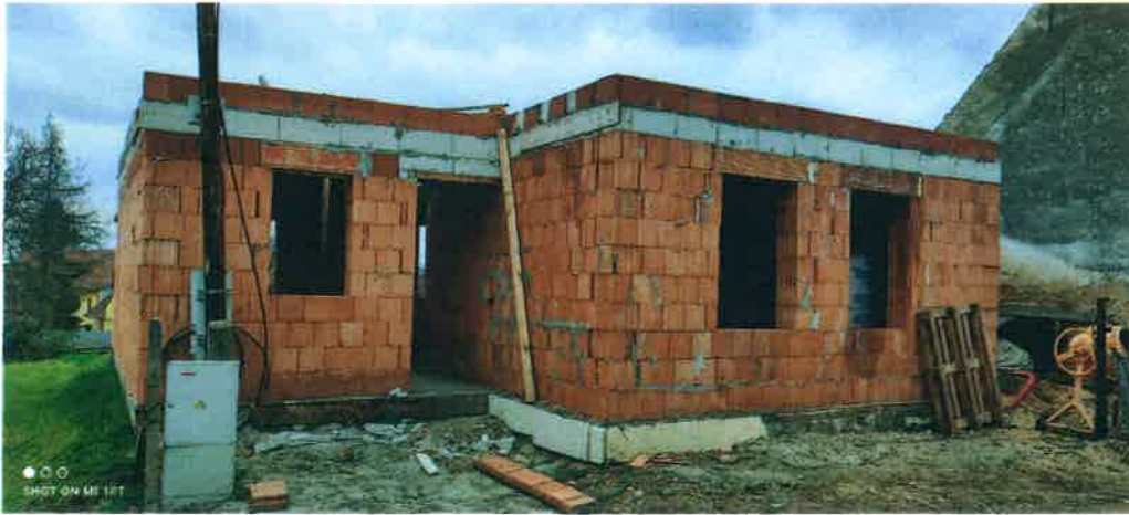
Obr. 2 – pohled na rozestavěnou stavbu RD
