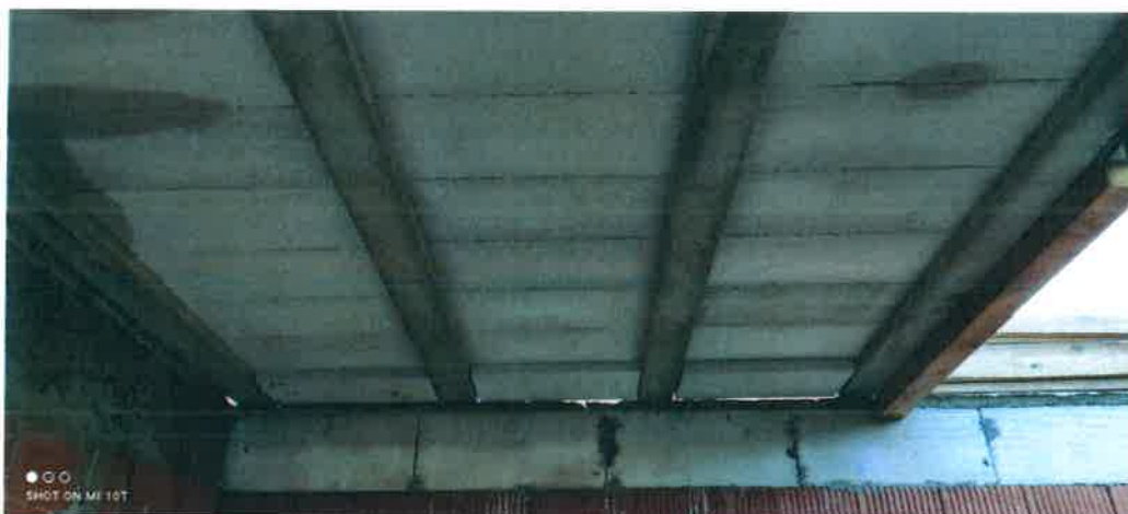
Obr. 11 – stropní nosníky ze systému Ytong klasik a místo stropních vložek výšky 200 mm jsou osazeny příčkovky Ytong tl. 100 mm
