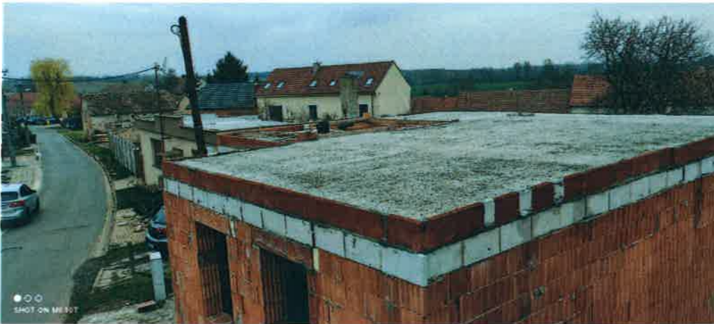
Obr. 3 – pohled na rozestavěnou stavbu RD
